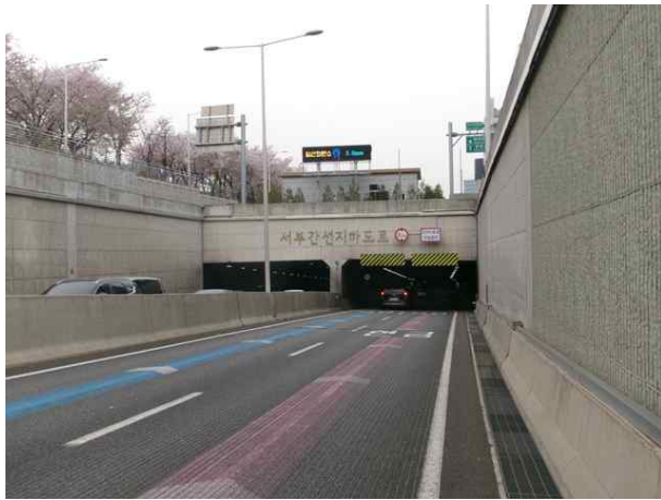
서부간선지하도로 성산방향 진입부
