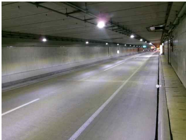
서부간선지하도로 내부 (BOX구간)
